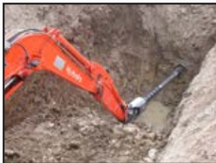
Testata con blocco per fori orizzontali. Locking head for horizontal holes.
