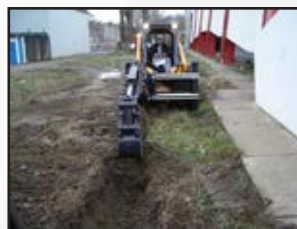
Fase di scavo di un fossato. Excavation of a ditch phase.
